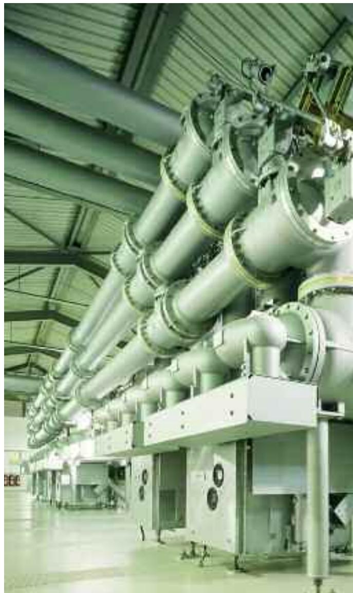
В системах высокого и среднего напряжения SF<sub>6</sub> используется во избежание разрядов. testo 6740 выполняет непрерывный мониторинг влажности, поддерживая диэлектрическую прочность дорогостоящего газа и позволяя избежать повреждений.
